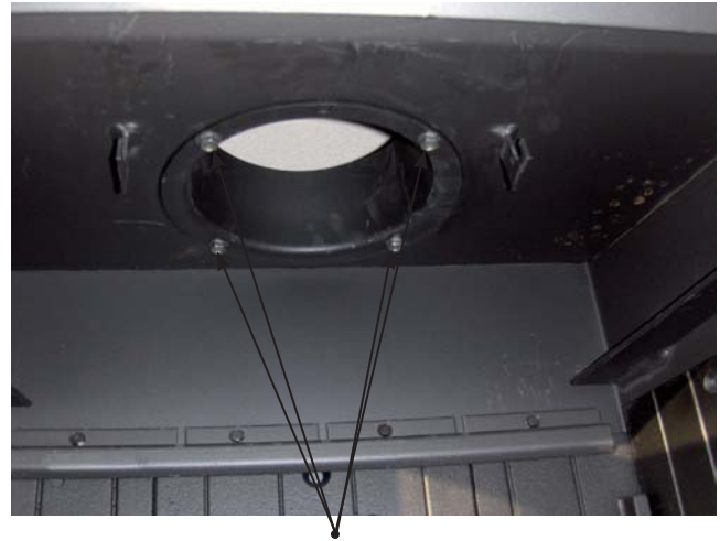
Figure 1 Enlèvement de la bouche de tuyau du poêle
