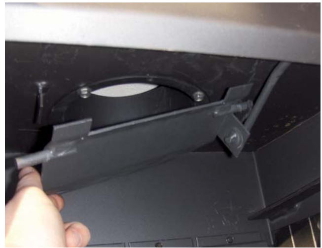
Figure 2 Mise en place du clapet économique et de la tige de poussoir
