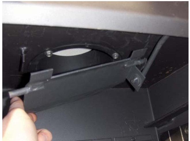
Figuur 2 Plaats de spaarklep en de duwstang.
