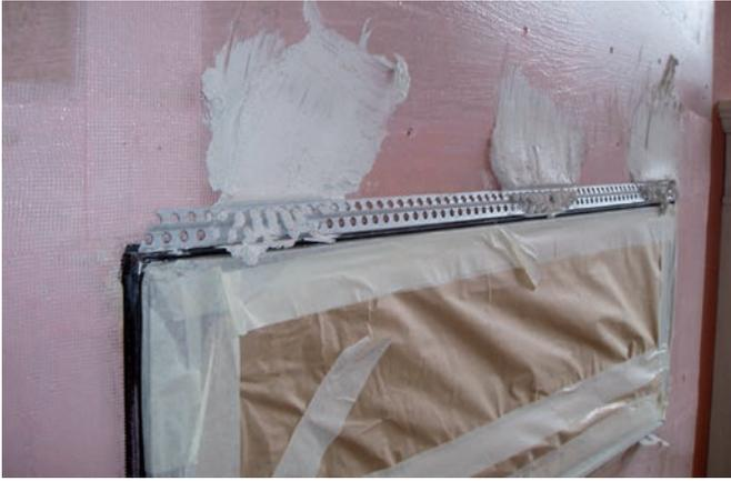
Lorsque le poêle est encastré, un espace d'au moins 5 mm doit être prévu entre le revêtement et le cadre encastrable.
