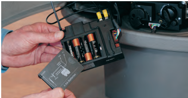
Remplacement des piles du récepteur
