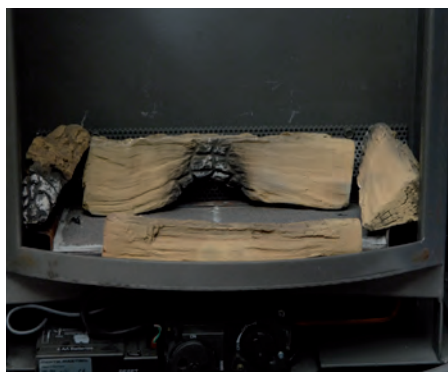
Arrangement jeu de bûches et gaz naturel
