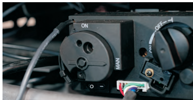
Le bloc de réglage du gaz.
